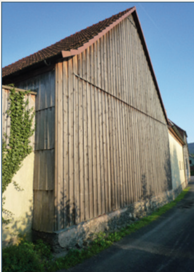
Nebengebäude mit senkrechter Boden-/Deckelschalung
