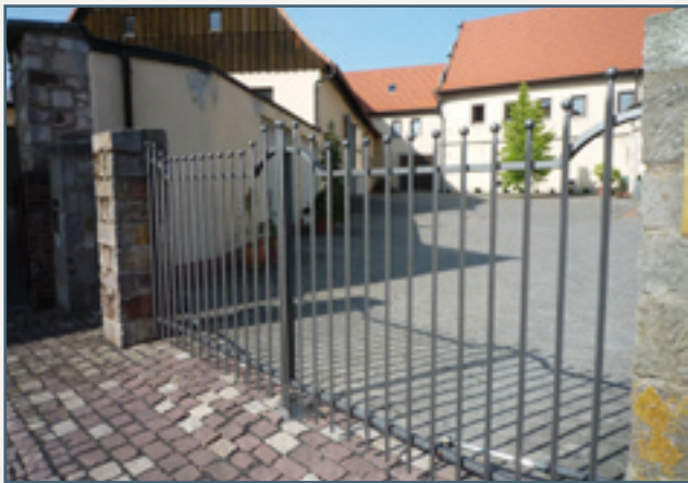
Schmiedeeisentor als Hofzugang in dunkelgrau gestrichen links: Eingangstüre in Schmiedeeisen
