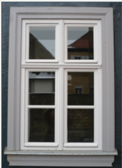
Kastenfenster mit Kämpfer und echter Regenschlagleiste
